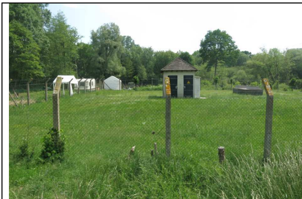
Périmètre de protection immédiate avec clôture grillagée et débord intérieur
